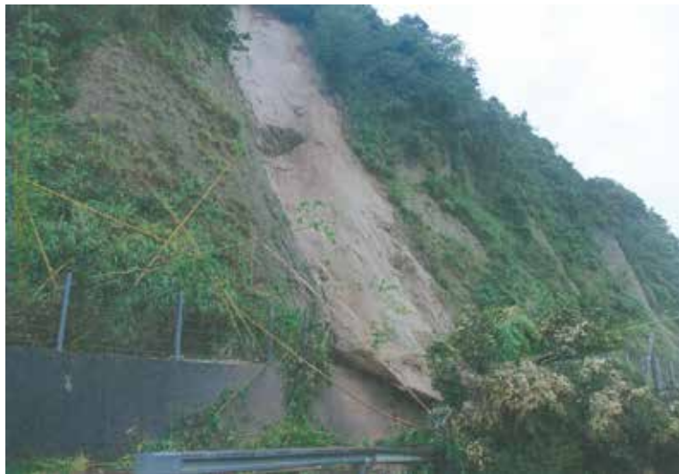
土砂や倒木が線路と国道へ流れ込んだ状況
